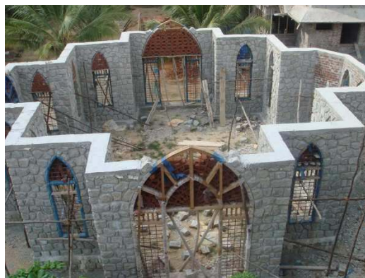
Die im Bau befindliche Kirche
