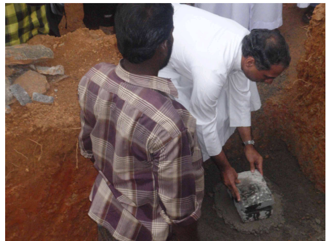
Grundsteinlegung durch Provincial Fr. Antony
